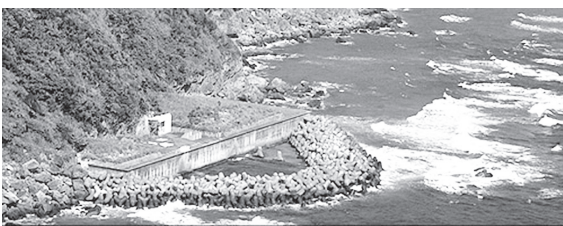
沖縄県にある海水揚水発電所の取水口
